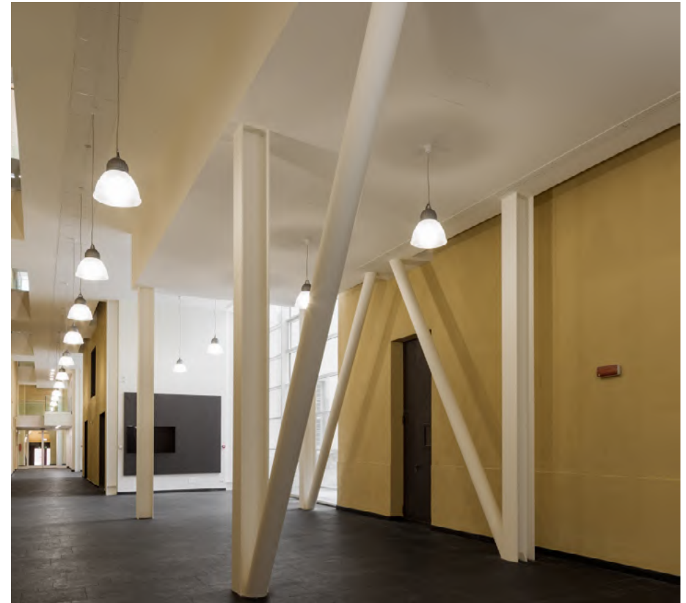
Santa Teresa, corridoio piano terra.
